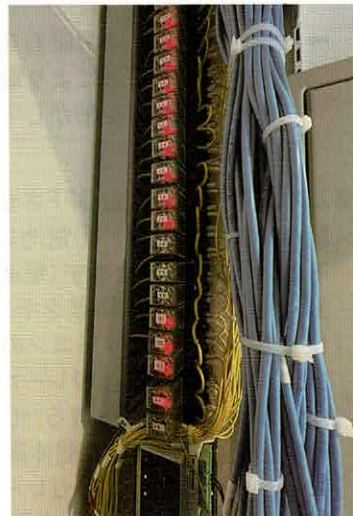
従来のIoT化した住宅における配線の様子。配線が複雑で設定にも手間がかかる
