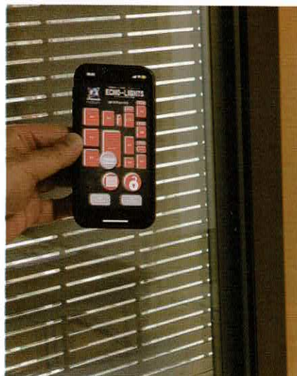
シンプルジェットでスマートフォンにつないだ電動シャッターをアプリで開閉している(千葉誠モデルハウス)
