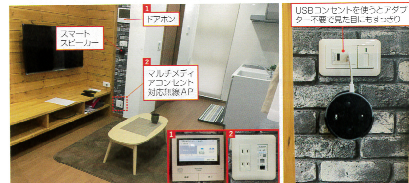
左/ Home IoTを導入した住戸。すっきりと納まってデバイスは目立たない。②の無線APを用いるとルーターやコードを露出させずに済む。右/スマートスピーカー Amazon Echo Dot。短いUSBコードを用いてすっきりと納める
