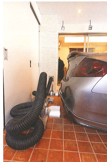
左/「EG Way Out」の本体は地下に埋設し、排煙ダクトは壁の内側に配しているため、フロアには耐熱ホースとアタッチメントのみというすっきりとしたレイアウト。右/砲弾タイプの片出しマフラーの場合は、アタッチメントを使わずに、排煙ダクトと直結している耐熱ホースをそのまま被せて使うことができる。
