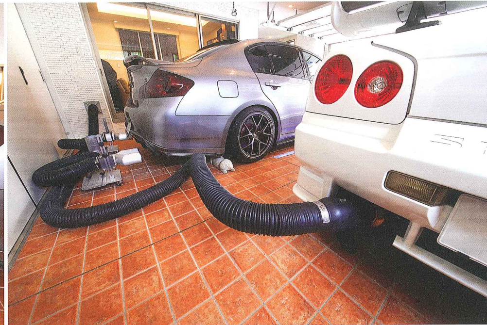
左/「EG Way Out」の本体は地下に埋設し、排煙ダクトは壁の内側に配しているため、フロアには耐熱ホースとアタッチメントのみというすっきりとしたレイアウト。右/砲弾タイプの片出しマフラーの場合は、アタッチメントを使わずに、排煙ダクトと直結している耐熱ホースをそのまま被せて使うことができる。
