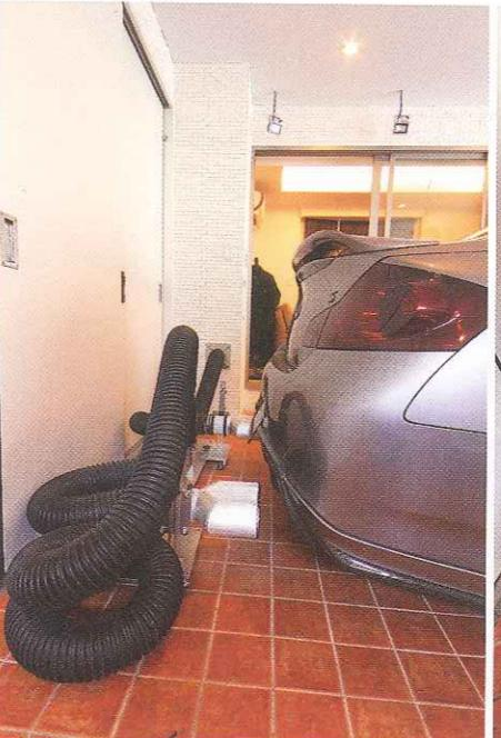
左／「EG Way Out」の本体は地下に埋設し、排煙ダクトは壁の内側に配しているので、フロアには耐熱ホースとアタッチメントのみというすっきりとしたレイアウト。右／砲弾タイプの片出しマフラーの場合は、アタッチメントを使わずに、排煙ダクトと直結している耐熱ホースをそのまま被せて使うことができる。
